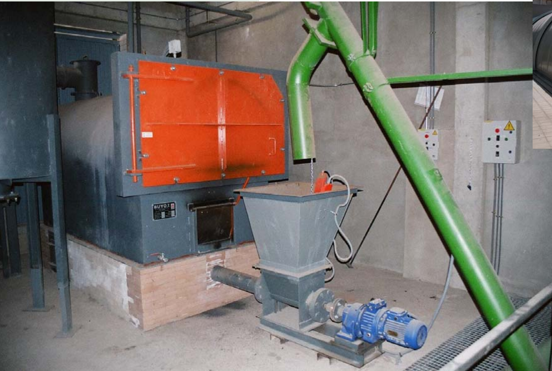
Caldera automática de 580 kW alimentada con hueso de aceituna en Cazorla (Jaén). Fabricante BUYO (España)
